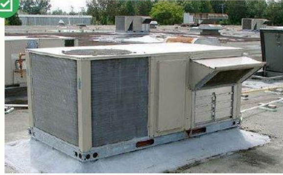
شكل رقم (7): تركيب وحدات خارجية على سطح الورشة
