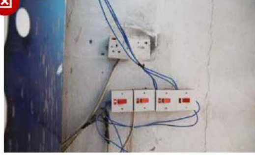
شكل رقم (5): الأسلاك والأنابيب الخارجية المكشوفة
